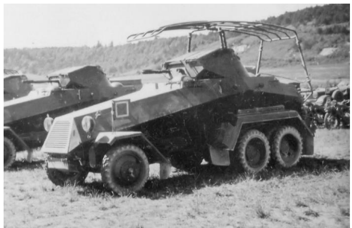
Auf der Grundlage eines taktischen 6-Rad-LKW-Fahrgestells begann die Panzer- und Motorisierungsabteilung des Waffenamts mit dem Bau der gepanzerten Aufklärungsfahrzeuge, die von der Reichswehr benötigt wurden. Das Ergebnis war die "Familie" der schweren Aufklärungsfahrzeuge Sd.Kfz.231, Sd.Kfz.232 und Sd.Kfz.263. Die Fahrzeuge der mittleren Baureihe waren - wie das Sd.Kfz.231 oben - mit einem Maschinengewehr ausgestattet, das rechts neben der Hauptkanone montiert war. Das Fahrzeug hat außerdem eine kleine Rolle an der unteren Front, um zu verhindern, dass es in einem Graben stecken bleibt. Später gab es diese Modelle mit 8 Rädern und Allrad.
